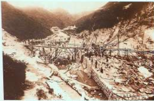
布引貯水池五本松堰堤建設時の様子
